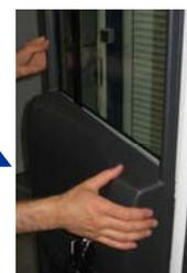
Orienter le doigt fixe de la serrure dans l'usinage en maintenant bien la garniture intérieure appuyée sur la porte.
