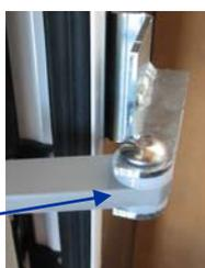
Remettre l'axe de l'arrêt de porte et clipper la rondelle.
